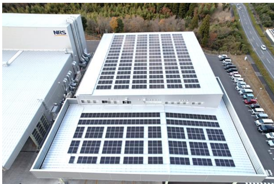
土気流通センター 一般棟屋上
